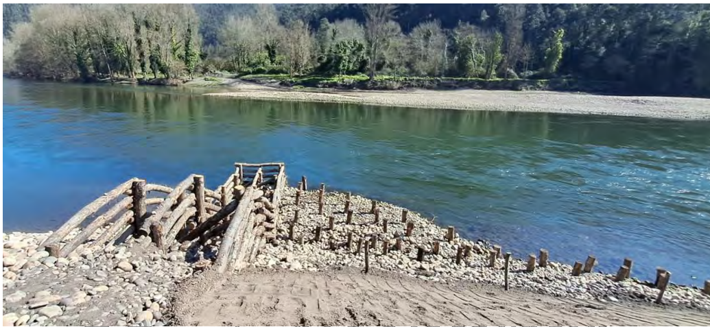
Figura 22. Imágenes durante las obras de bioingeniería en 2022.
