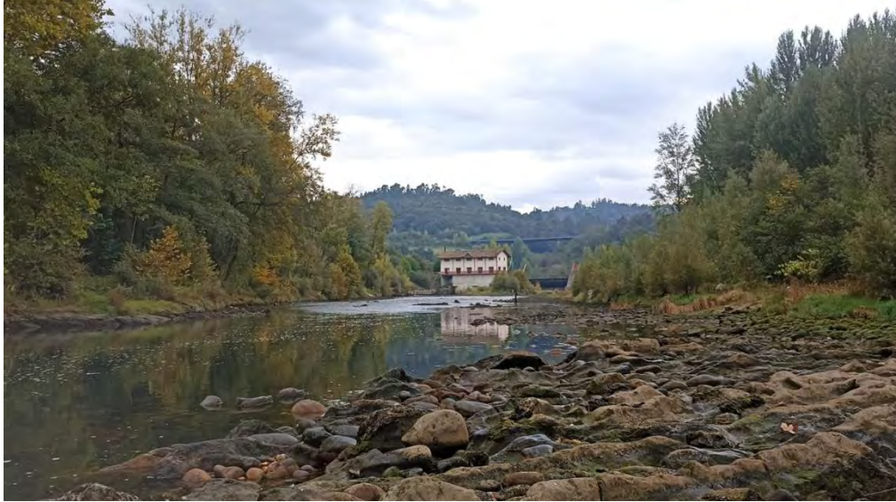
Figura 5. Afloramientos rocosos en el lecho del cauce aguas abajo de la presa de Valduno.
