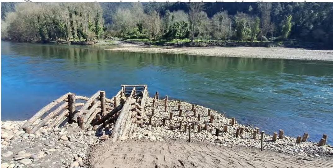
Figura 8. Imagen de los deflectores recién construidos en el año 2023.
